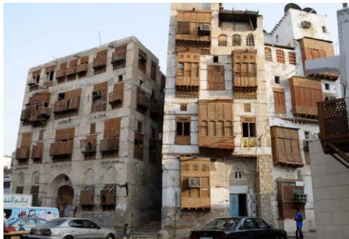
الشكل (2-10) يوضح مبنى تراثي في المنطقة التاريخية بجدة
