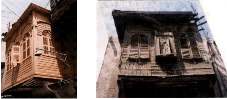
الشكل (2-8) يوضح ترميم عناصر معمارية، تجربة حلب في إحياء المدينة القديمة
